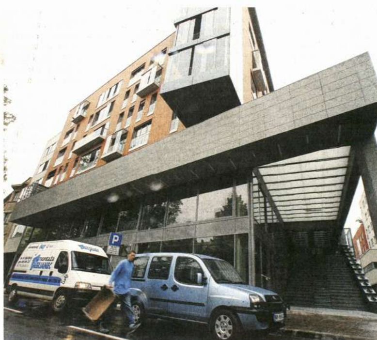
V Sloveniji je že zdaj praznih 90.000 stanovanj, od tega 20.000 v mestnih občinah. © Jaka Adamič
